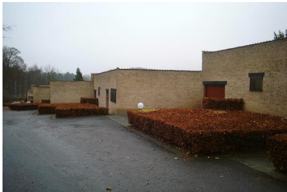
図 22: フレデンスボーのテラスハウス
