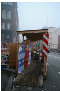
図 62 : 工事中の仮設歩行者通路 デンマーク
