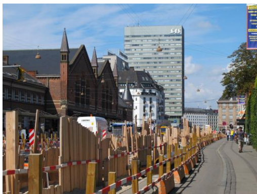
図 64 : 工事中に設けられる工作物 デンマーク
