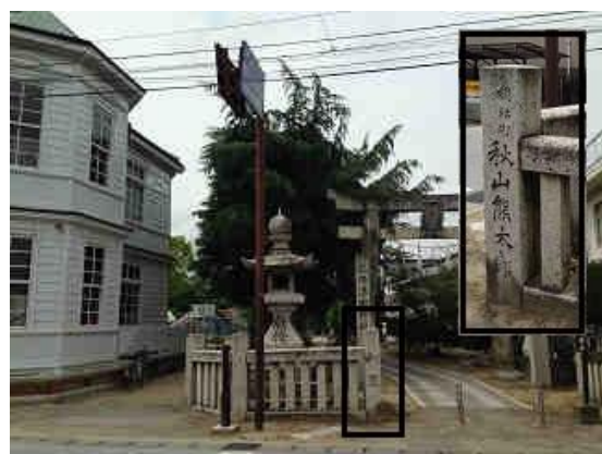
写真 4 まちかど郷土館と総社宮南参道
