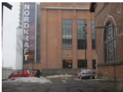
図11 NORDKRAFT (デンマーク) 工場のコンバージョンによる文化施設
